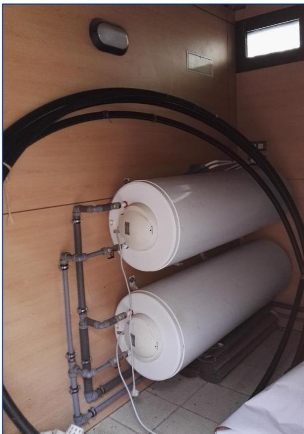
Acumuladores existentes actualmente. Se procede a su retirada y sustitución por tres nuevas bombas de calor.
