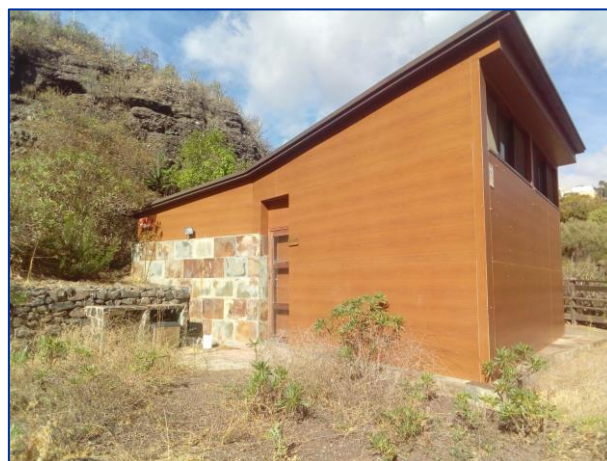
Edificio de la cocina.
