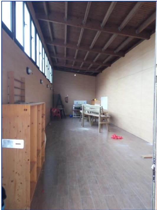
Interior del aula. Sobre su cubierta irán 20 placas.
