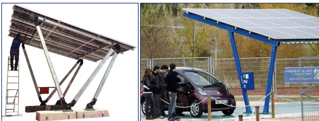
**Ilustraciones 28 y 29. Ejemplos de marquesina para electrolinera solar.**
