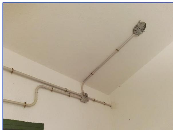
*En los vestuarios, robaron todo el cableado. Tras la sustitución de las puertas por otras que impiden los robos, se procede a restituir el cableado y las luminarias. Ahora la fuente de suministro será la nueva instalación fotovoltaica. Los tubos se aprovechan.*
