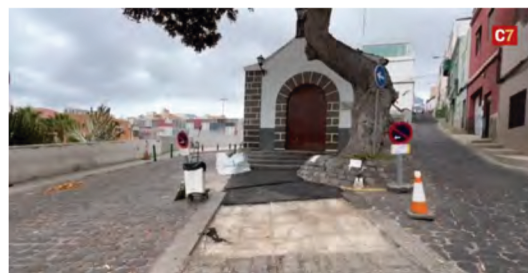
Obras recientes en el entorno de las raíces
