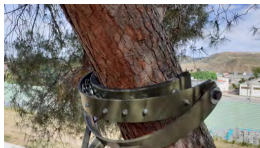
Sistemas de anclaje de cimales
