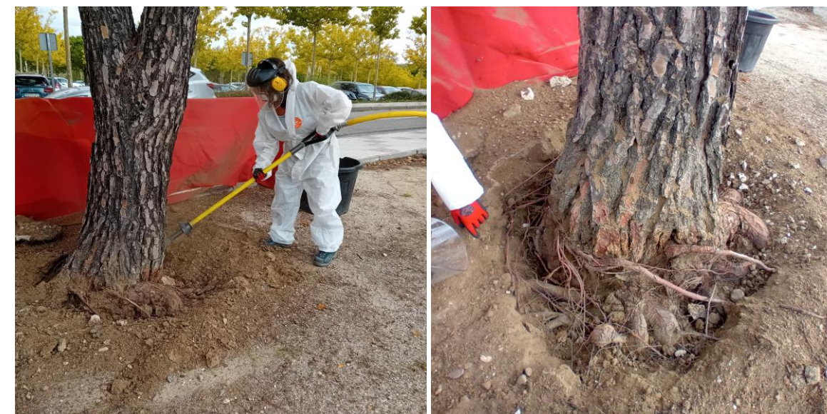
Fig. 25: Air spade y resultados obtenidos.
