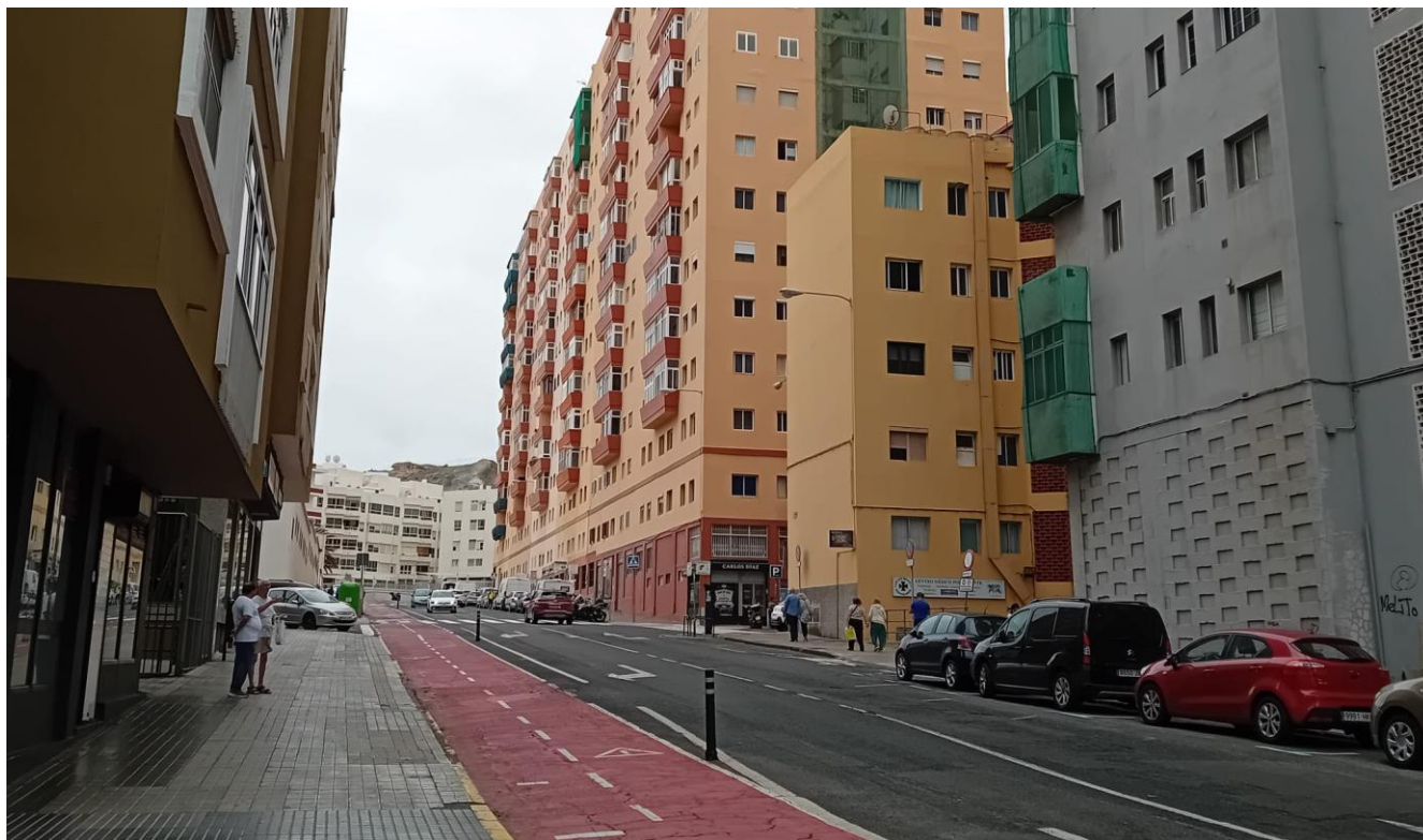
Fig. 20: Callen, aceras y carril bici sin sombras, aumentando el efecto de la isla de calor. Fuente: Elaboración propia en la Calle Churruca, LPG.
