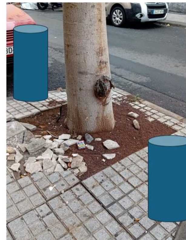
Fig. 8: Representación de ubicación de bolardos para evitar el golpe de los vehículos al aparcarse. Fuente: Elaboración propia en la calle Mariucha, LPG.
